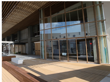
ウッドデッキの整備イメージ (西区総合庁舎)
